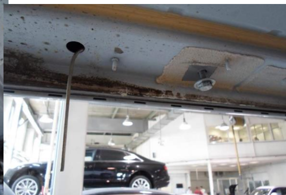
Рис.3 Место крепления среднего кронштейна
