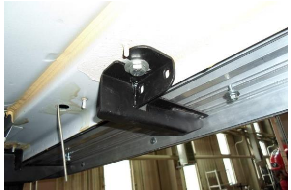
Рис.7 Установка среднего кронштейна
