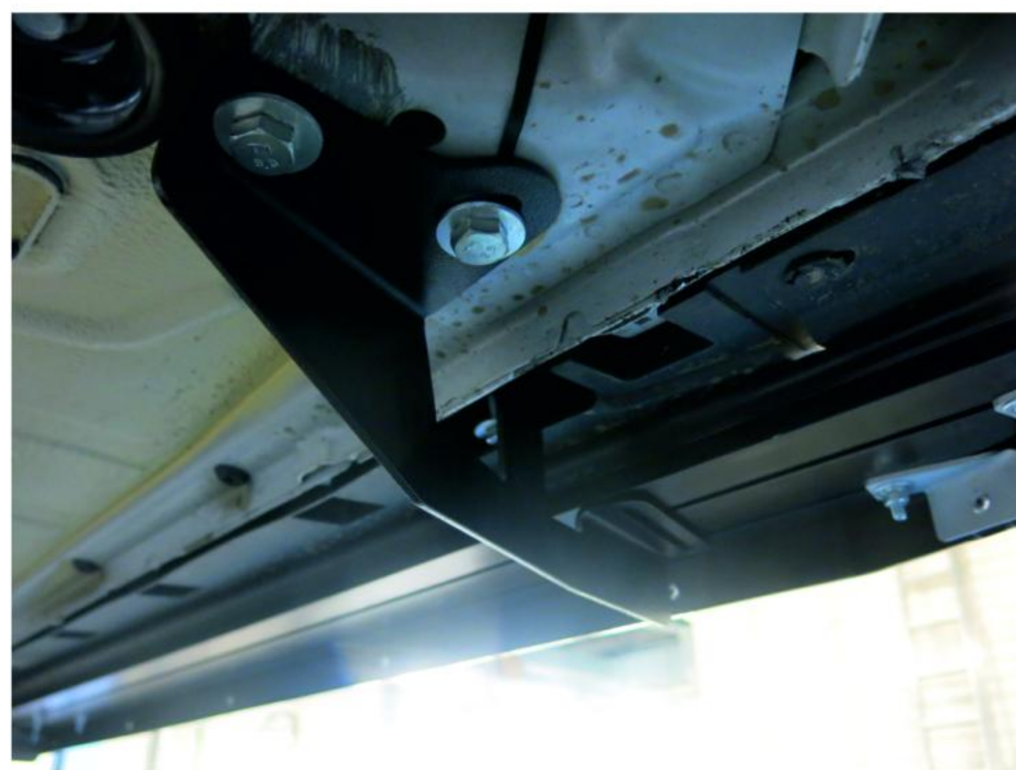
Рис. 4 - Установка переднего кронштейна
