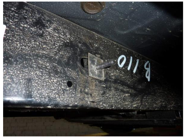
Рис.7 Установка шпильки закладной M10x43x90/20 в месте установки среднего и заднего кронштейна
