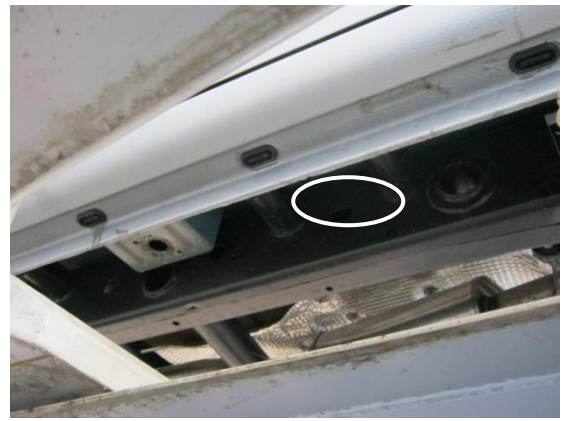
Рис.3 Установка шпильки закладной для среднего кронштейна
