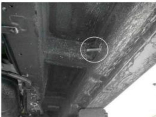
Рис.4 Установка закладной для среднего кронштейна
