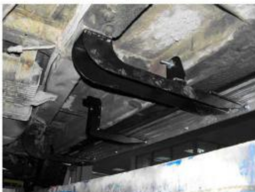
Рис.6 Установка переднего кронштейна
