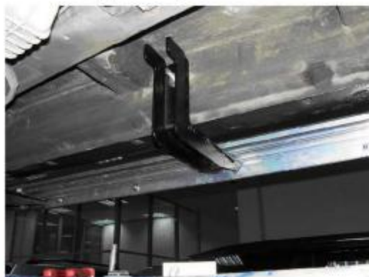
Рис.7 Установка среднего кронштейна
