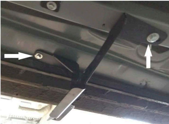
Рис. 5 - Установка среднего кронштейна
