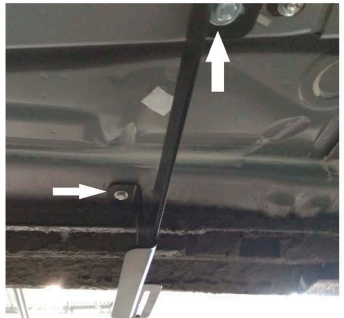
Рис. 4 - Установка переднего кронштейна
