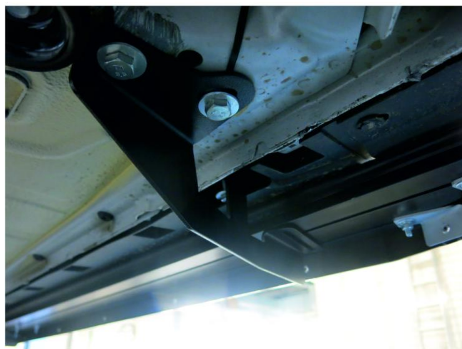
Рис. 4 - Установка переднего кронштейна
