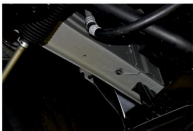
Рис. 2 - Установка закладной гайки
